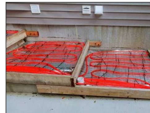
Figure 18 : réseau de tubulure pour trottoir (©CanStockPhoto.com)
