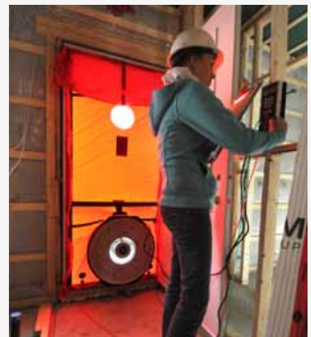
Une inspectrice note les résultats d'un test d'infiltrométrie.
