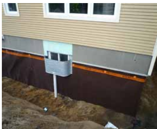
Aperçu de l'installation d'une margelle Crédit: E.Cosgrove
