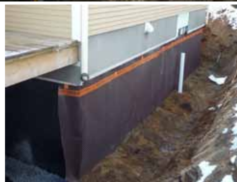
Travaux visant à isoler et à améliorer l'étanchéité de murs de fondations à partir de l'extérieur. Crédit: E. Cosgrove
