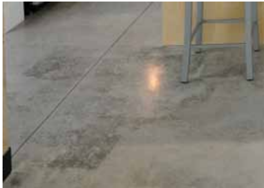
Aspect visuel du béton poli, type de plancher très écologique. Il est offert en une multitude de teintes et de finis.
