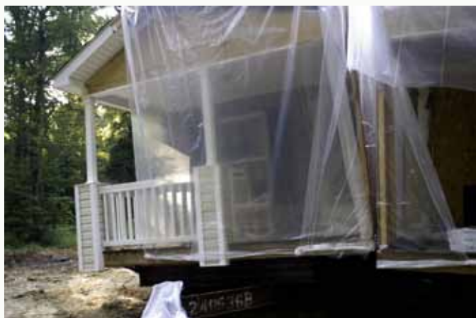
Une maison usinée de type modulaire telle qu'elle paraît à sa livraison chez une cliente.
