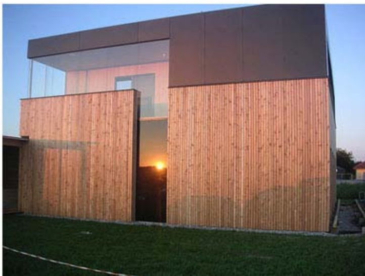
Une maison passive en Autriche Photo Train Bird, licence Creative Commons
