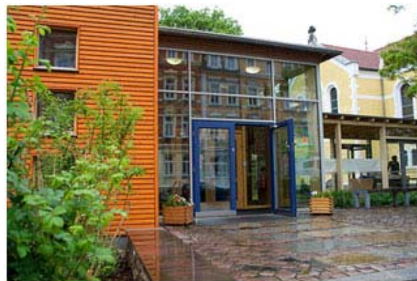
Un bâtiment solaire passif avec solarium à Dresde (Allemagne)
