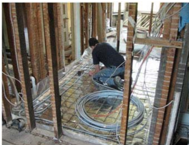
Installation d'un système radiant
